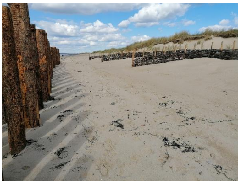
Figure 9 : Exemples d'aménagement de pieux hydrauliques et fascines
